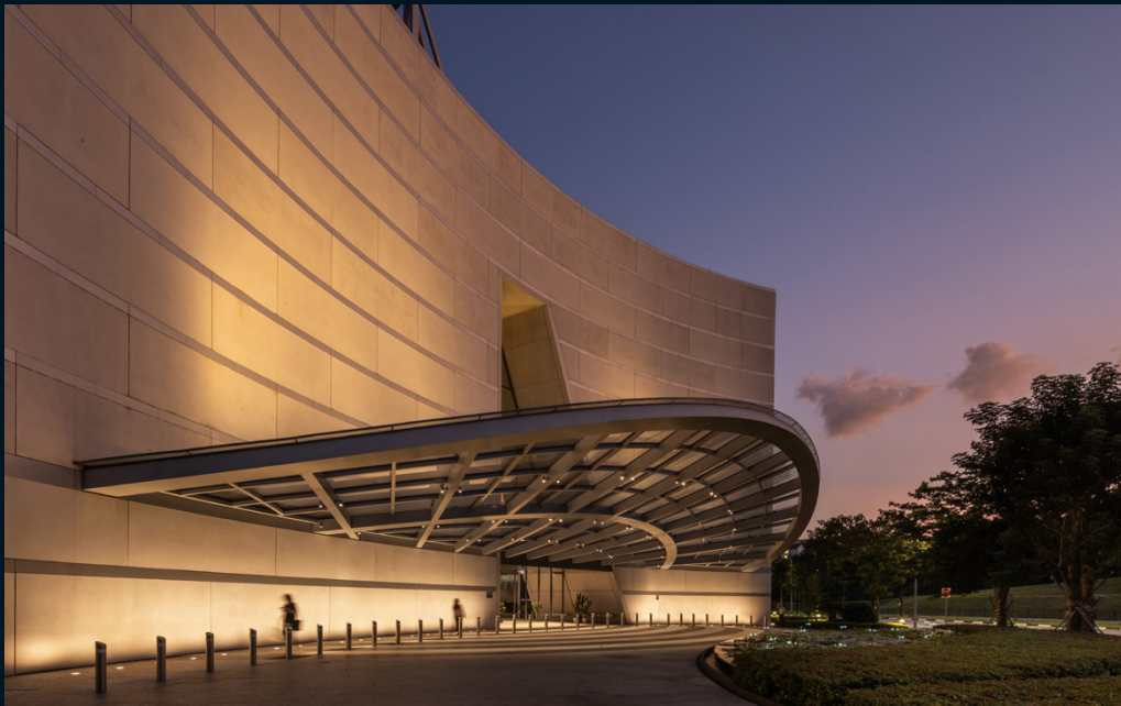
Surbana Jurong Campus, Singapur Die im Innendach des Haupteingangs installierten Einbauleuchten integrieren sich harmonisch in das architektonische Konzept. Lichtplanung: Nipek Pte. Ltd. Fotografie: Finnbar Fallon
